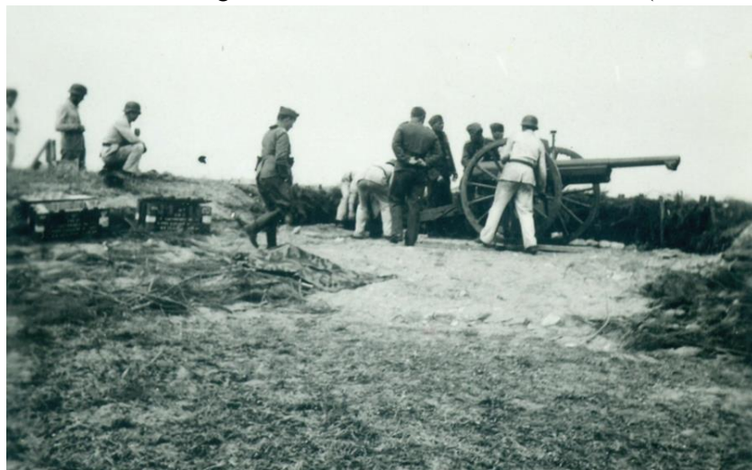
Figure 10 : Mise en place de l'artillerie sur le site de l'ancien réduit de la Pointe Gauthier par les allemands en 1943. Photo extraite du Mur de l'Atlantique en Vendée. Tirée de Chazette, 2008.
