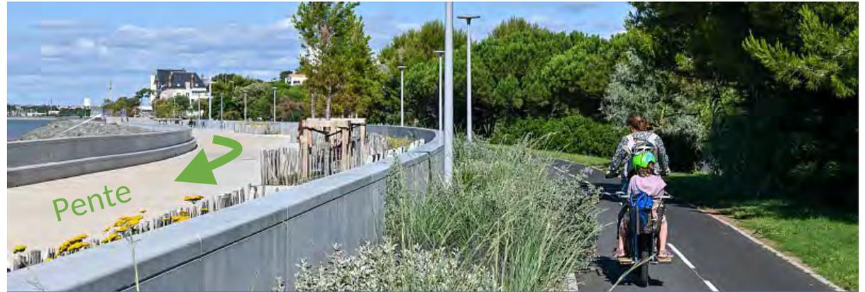
7 Système de double muret + rampe (cliché inversé pour être dans le même sens que le schéma)
